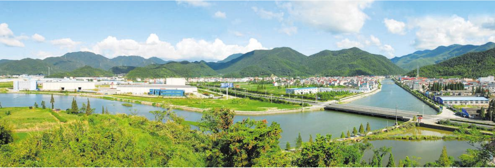
西周镇下沉区域一隅
