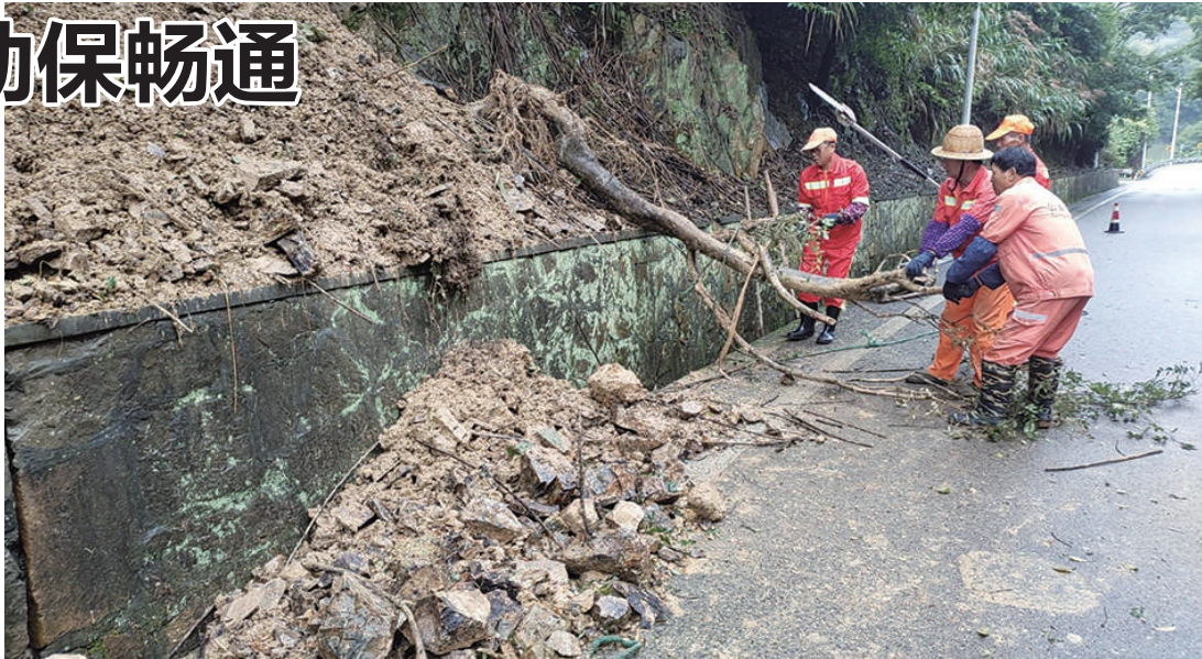
6月26日上午，在沙新线K24路段，县交通运输局基层养护人员在清理泥石、树枝。
